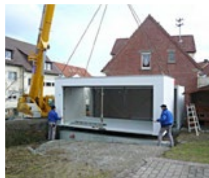
Mise en place d'un garage avec une grue
