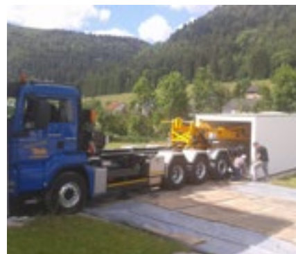
Déplacement d'un garage avec camion spécial
