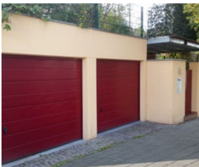
Garage double enterré, avec garde-corps...
