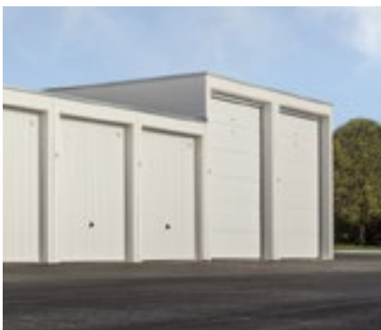
Garages de différentes hauteurs, en rangée
