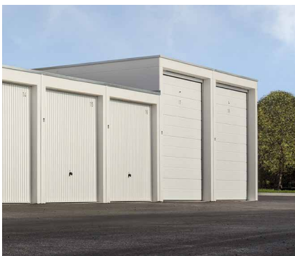
Garages de différentes hauteurs, en rangée
