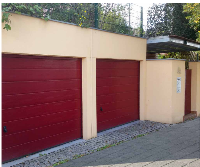
Garage double enterré, avec garde-corps...
