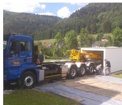
Déplacement d'un garage avec camion spécial
